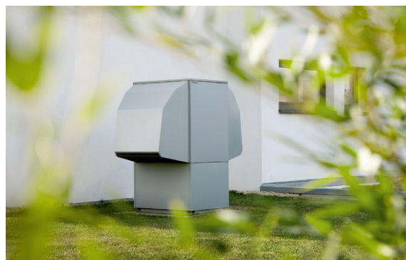
Abb. 5.2 Luft/Wasser-Wärmepumpe in Außenaufstellung
