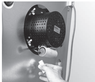
Fig. 58 Gebläsestecker abziehen und Flügelmuttern entfernen
