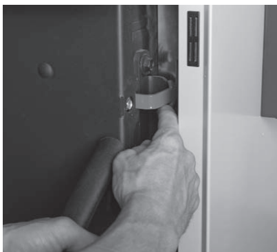
Fig. 41 Fülltür-Sperre öffnen
