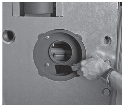
Fig. 60 Gebläsekasten innen reinigen
