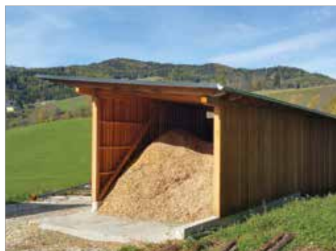
Hackgut trocken, luftig und nicht verdichtet zwischenlagern
